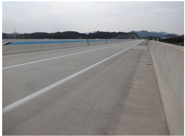
교량 상부 전경
