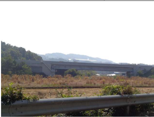
교량 측면 전경
