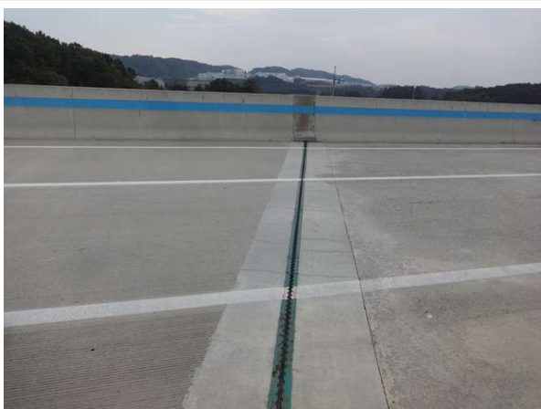
교량 상부 전경
