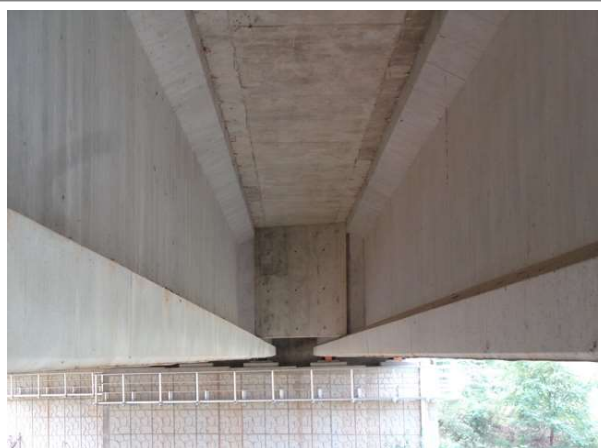
교량 거더 전경
