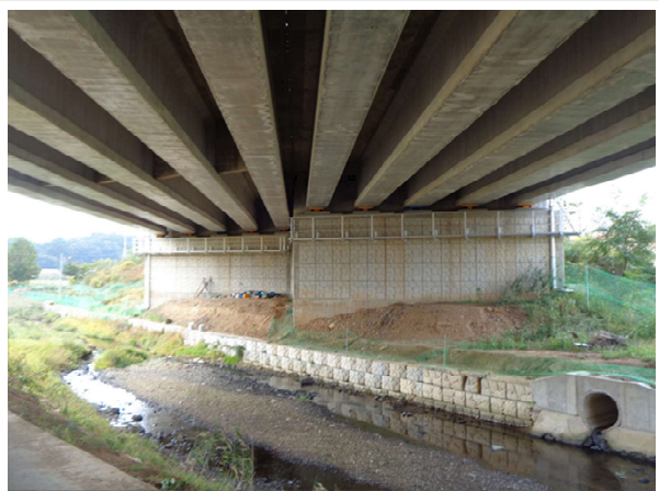
교량 하부 전경
