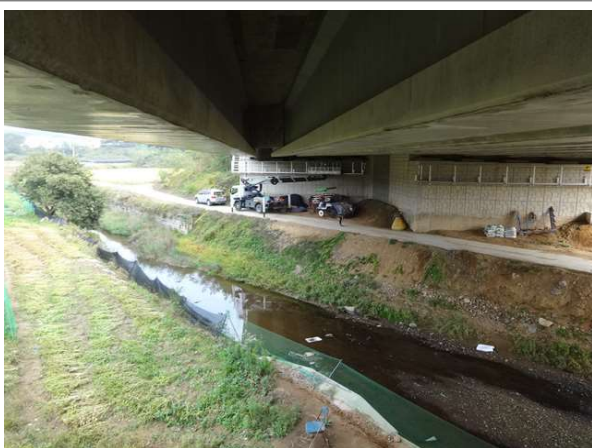
교량 하부 전경
